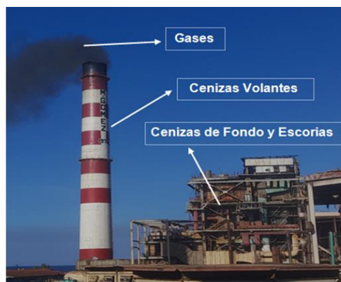
Imagen 1: Caldera de vapor y chimenea de expulsión de gases. CTE Máximo Gómez, Mariel
